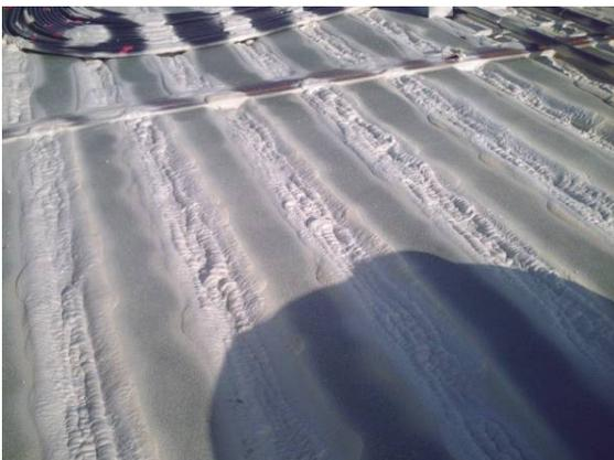
Fugenverfüllung aufdach bei einem Faulturm
