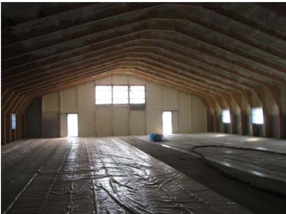
Unterdachverschäumung einer Halle
